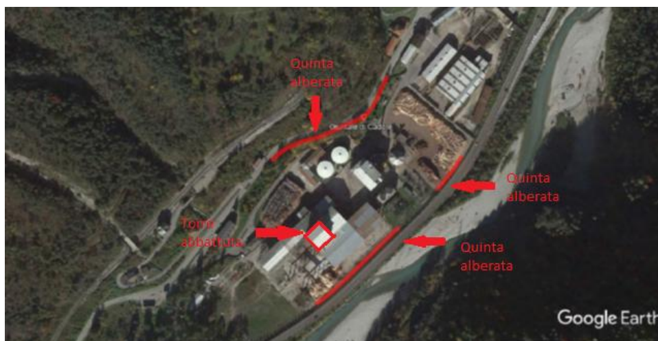
Figura 24: Immagine satellitare del sito industriale con evidenziazione degli interventi effettuati (fonte: google earth; nord in alto.)
