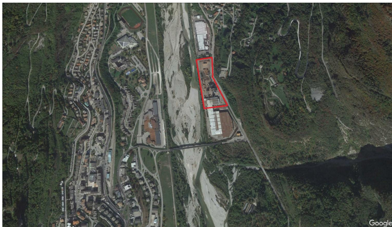
Figura 1: Vista stabilimento CEB (fonte: google earth; orientamento: nord in alto)
